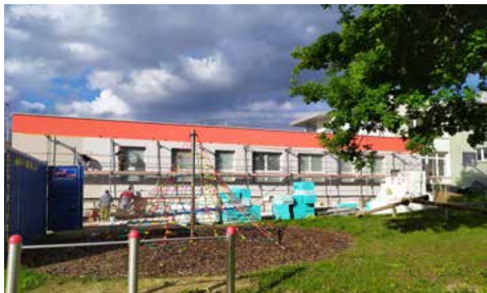
Práce na zateplení a nové fasádě jsou v plném proudu
