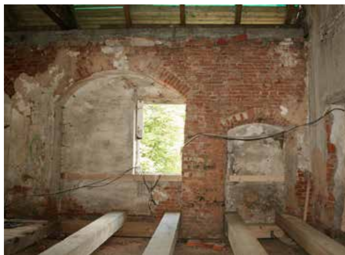
Dnes již zazděný vstup z velkého sálu na pavlač, foto, 2013
