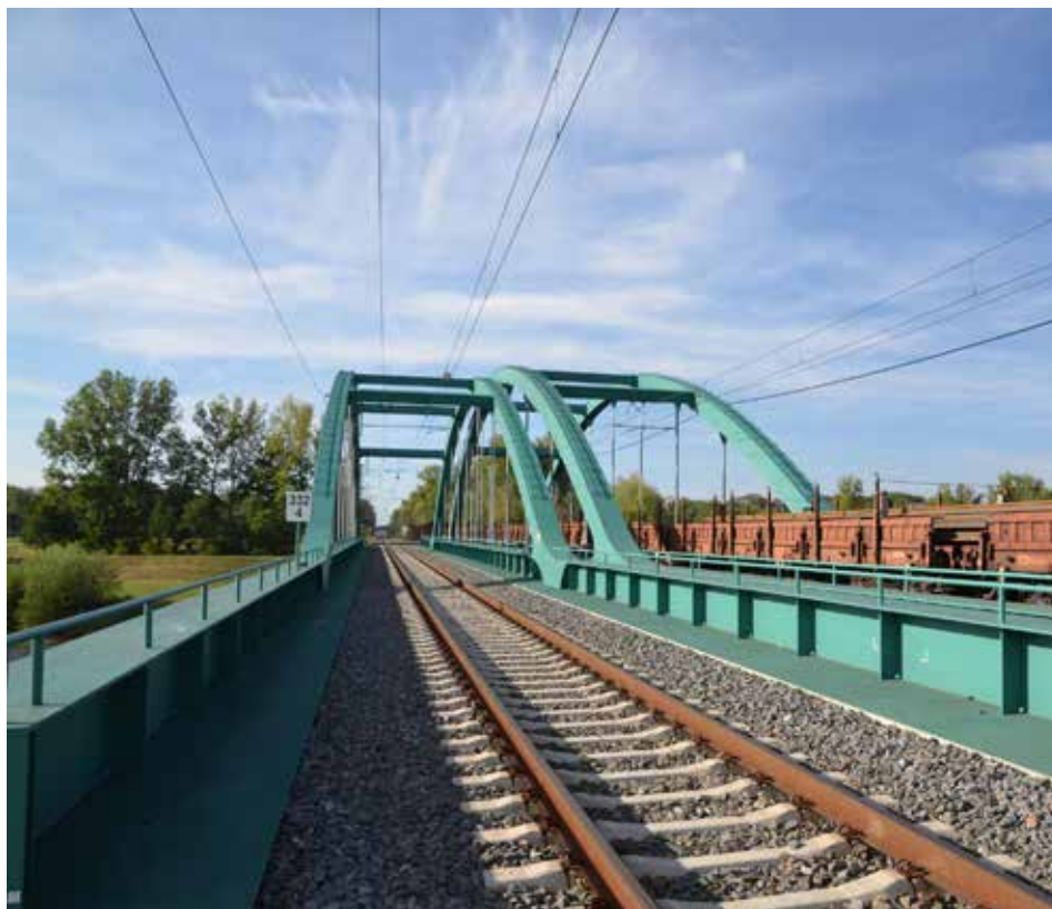
Modernizovaná trať mezi Dětmárovicemi a Českým Těšínem zlepší komfort i bezpečnost cestování
