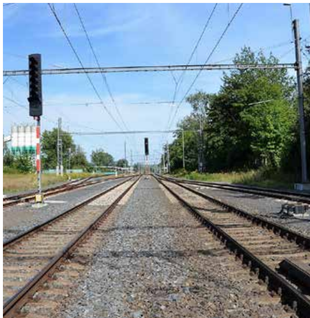
Po rekonstrukci ve Vítkovicích se zvýšila rychlost o 40 km/h
