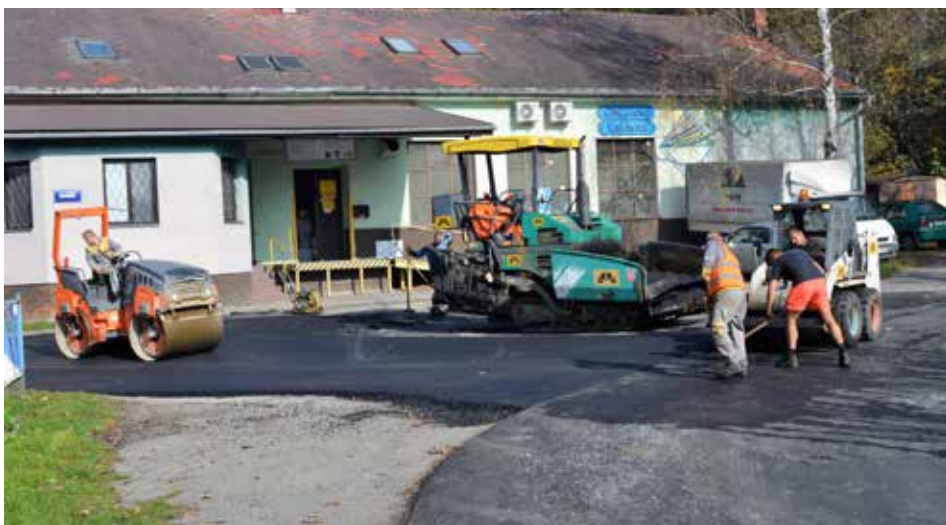
Celoplošnou opravu má za sebou také frekventovaná ulice Garážní
