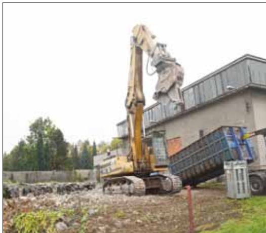
Stará mazutová kotelna definitivně zmizela z mapy Rychvaldu. Její demolice byla jednou z nejvýznamnějších investičních akcí loňského roku.
