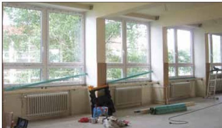
V roce 2010 proběhla na základní škole výměna oken
