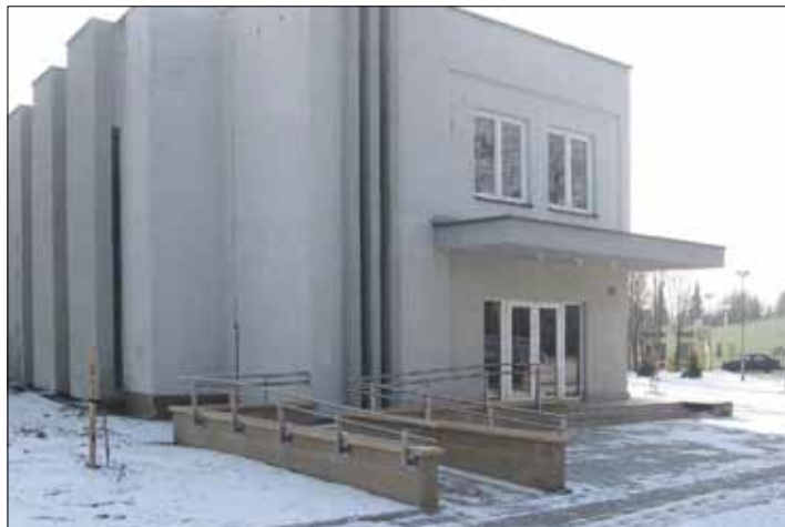
Bezbariérový vstup do smuteční síně
