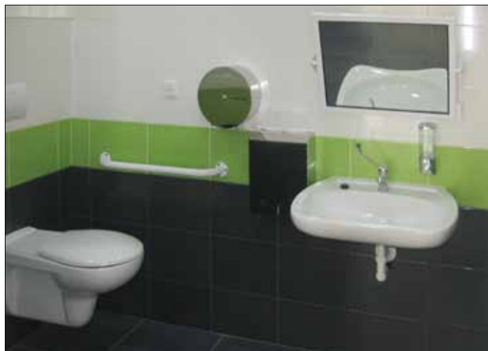
Nové sociální zařízení v budově zdravotního střediska
