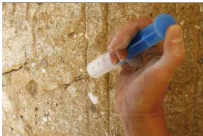
Injektáž dutých míst směsí na vápenné bázi (foto M. Müllerová 2014)
