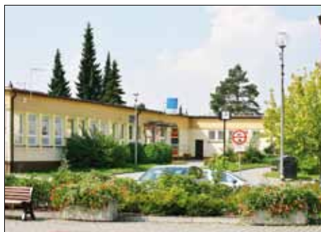
Zdravotnické středisko prošlo vnitřní rekonstrukcí
