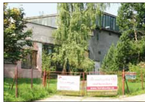
Tento pohled na bývalou mazutovou kotelnu začal patřit minulosti
