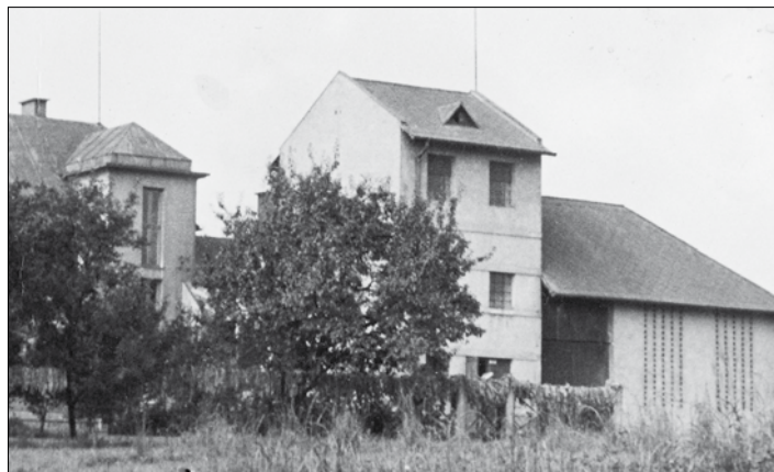
Lukšův mlýn na ulici Lutyňská u č. pop. 149
