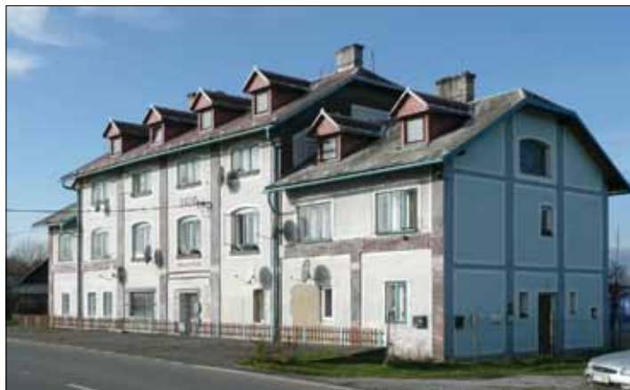
Bývalý parní mlýn č. p. 657 na ulici Orlovská
