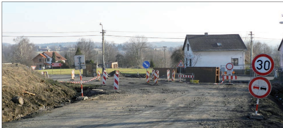
Rekonstrukce Bohumínské už probíhá. Zde brzy vznikne kruhový objezd.
