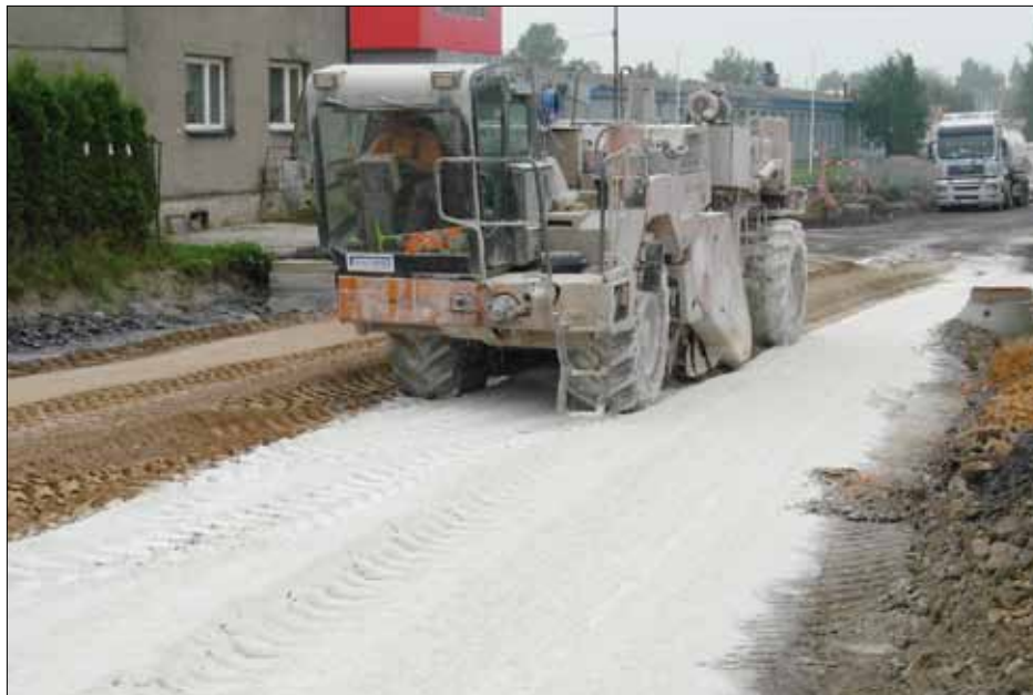
Momentka z prací, které probíhaly při rekonstrukci Bohumínské
