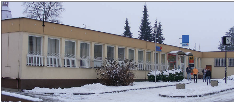
První ordinace MUDr. Winklerové se nacházela v místě dnešní pošty. Po roce 1990 došlo k rekonstrukci zdravotního střediska a přesunutí dětské ordinace do současných prostor
