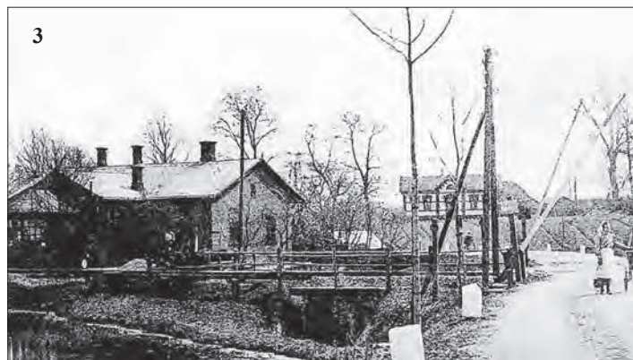
3 Obrázek za staré pohlednice, na níž je třetí „nádraží“. Pro toto nádraží a odtud i pro blízké okolí se vžil název Azvajch z německého Ausweiche – výhybka
