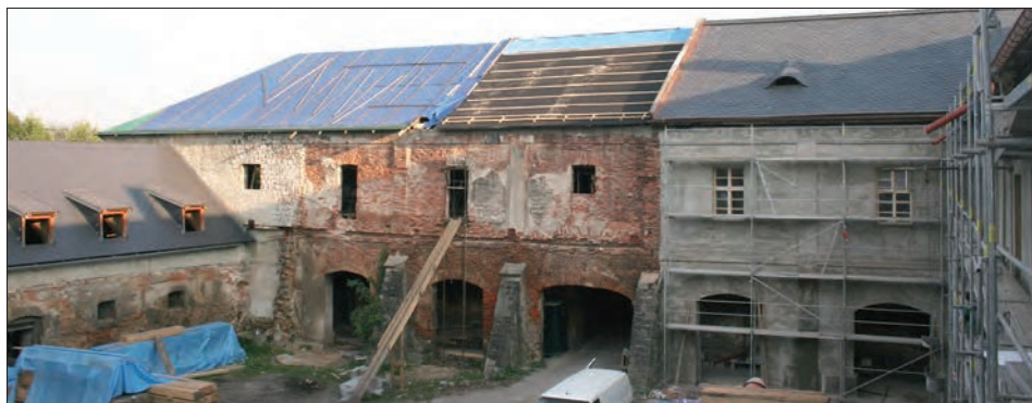
Jižní průčelí severního křídla při opravách arkády v roce 2010
