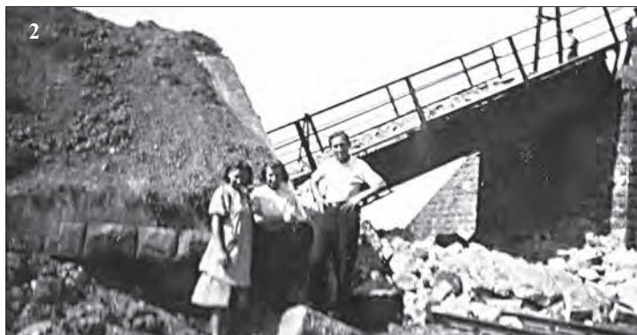
2 Zničený most nad železniční tratí před příchodem německé armády
