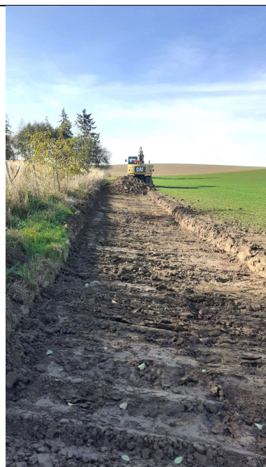
Práce na zpevnění cesty ke druhému dolu.
