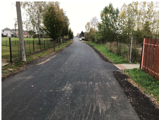
Místní komunikace ulice Horní
