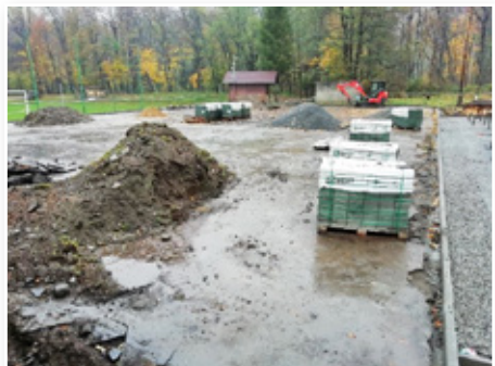
Asfaltová plocha během úpravy...
