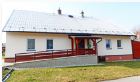
budova č.p. 17 po rekonstrukci nyní
