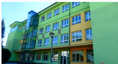
Budova ZŠ čelní pohledy
