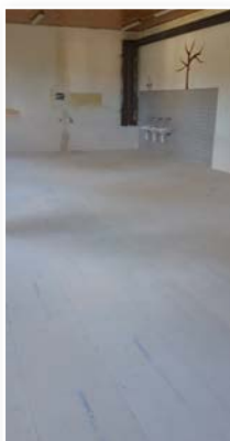
Podlaha v dílnách PO rekonstrukci
