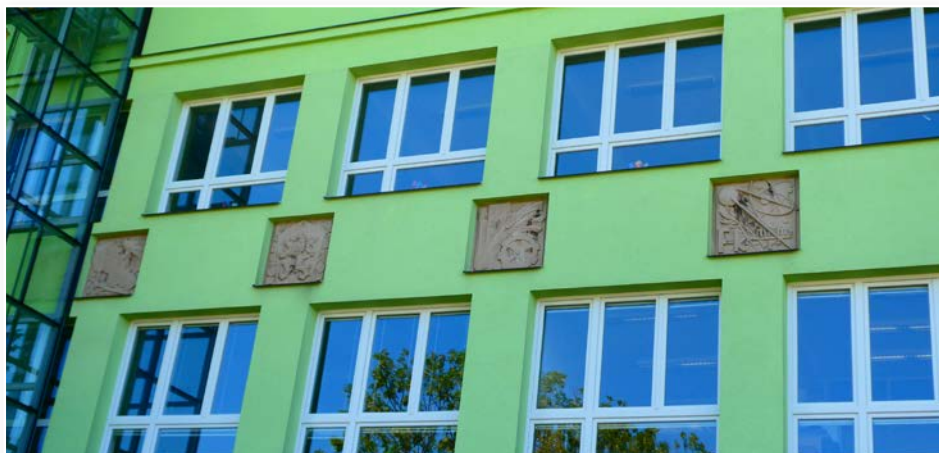
Budova ZŠ detail
