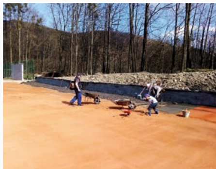
Foto ze dne 7.4.2019 zachycující práce na novém antukovém povrchu kurtu č. 2
