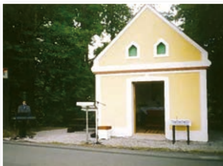
Mariánská kaple po opravě
