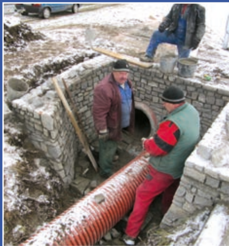
Oprava propustku u kaple
