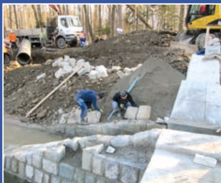
Oprava propustku u kaple
