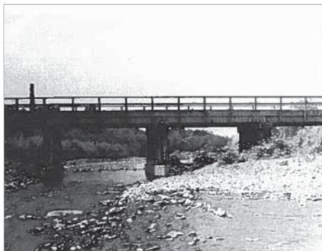
Dřevěný pilířový most
