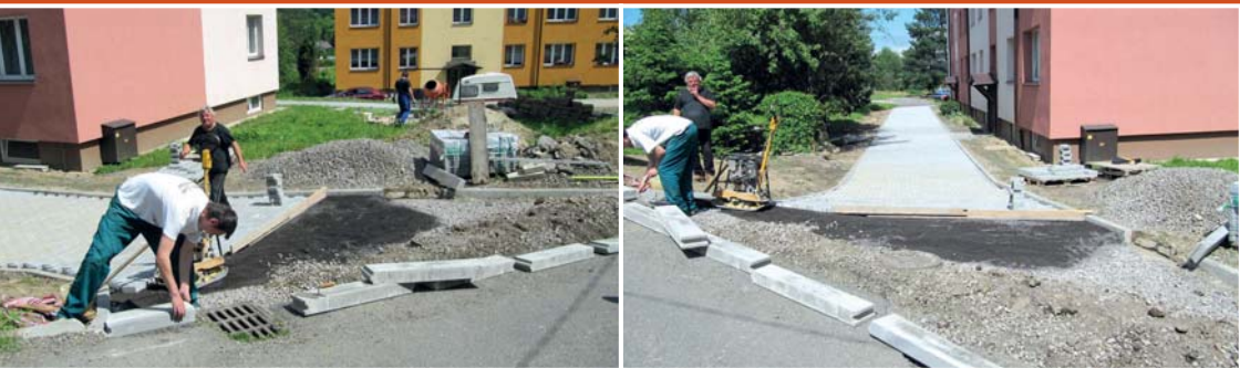
Příjezdová cesta k bytovým domům
