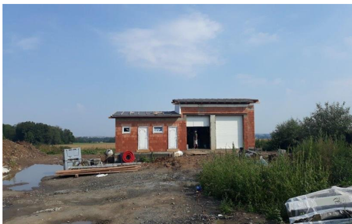
Technická budova budoucí ČOV. Za budovou jsou umístěny čisticí nádrže
