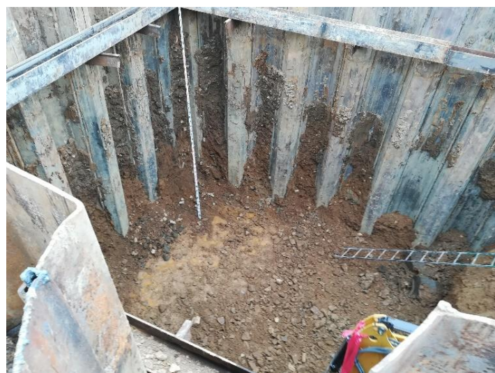
Jáma pro budoucí čerpací stanici
