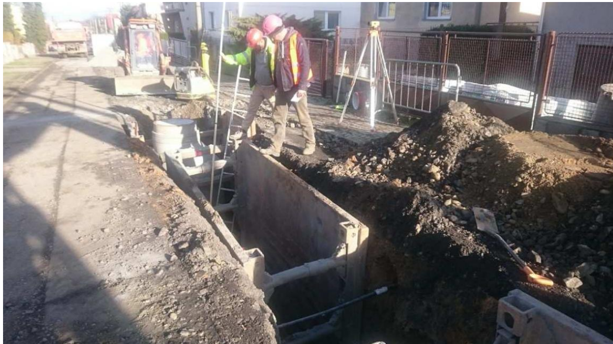
Práce na ulici Mírová – zaměřování potrubí ve výkopu
