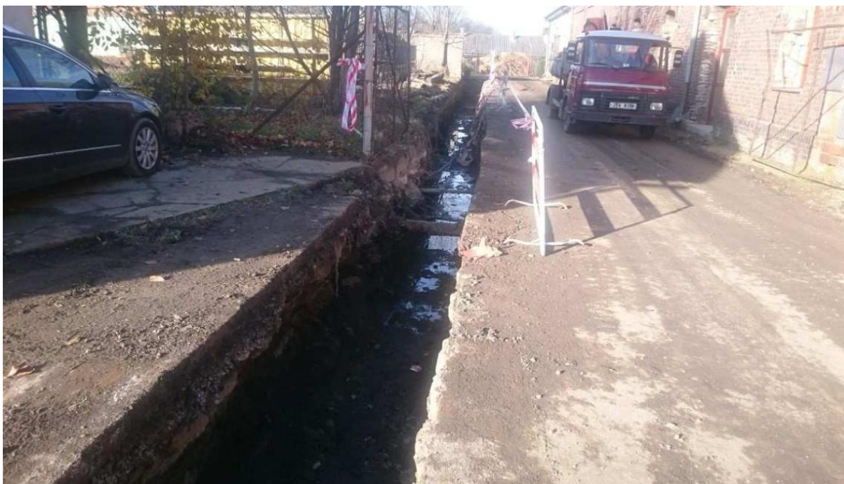
Nový výkop u cesty vedoucí k budoucí ČOV
