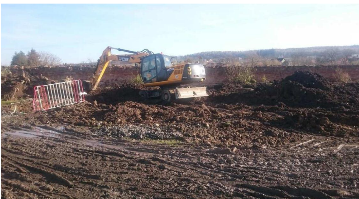
Terénní úpravy v místě budoucí ČOV
