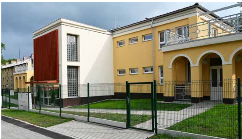
Poslední pobočka knihovny, která čekala na modernizaci, se otevíře v září na Šumbarku v budově Santé na ulici U Jeslí.
