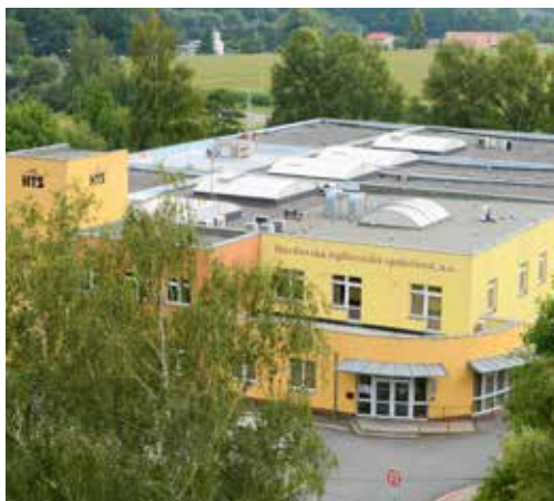
HTS chce na střeše svého sídla vybudovat fotovoltaickou elektrárnu, která bude mít okolo 400 kusů solárních panelů
