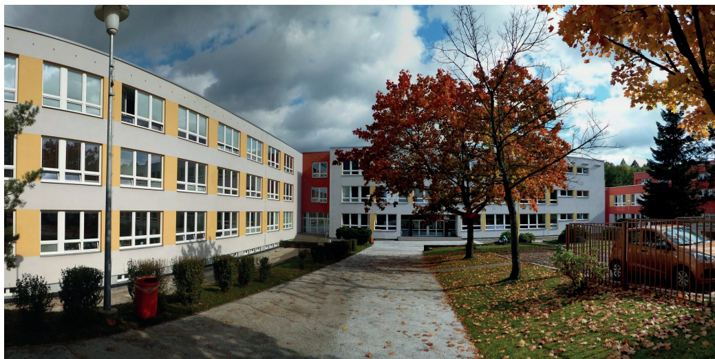
V Základní škole Františka Hrubína proběhla o prázdninách kompletní rekonstrukce elektroinstalace. Datové rozvody už tady mají hotové.
