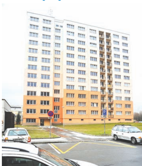
Ubytovna Střední, Havířov-Šumbark
