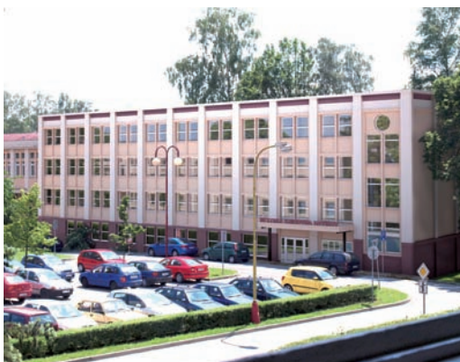
Přestavbu zahájili stavbaři vybouráním přiček.
