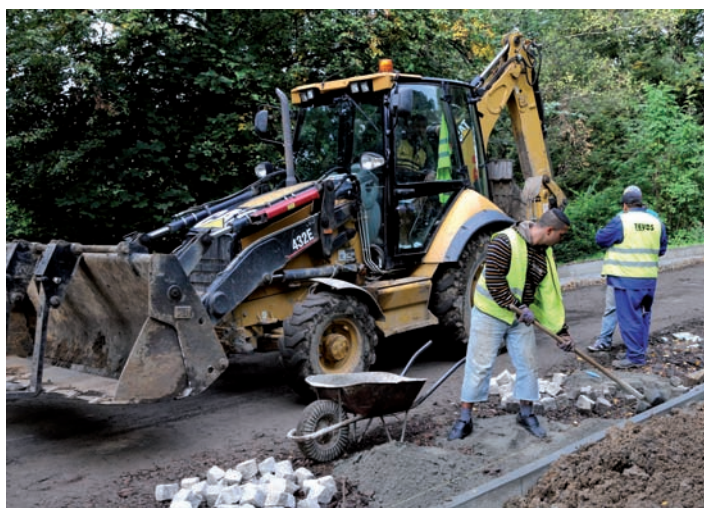
Jednou z právě probíhajících investičních akcí, na kterou Havířov získal dotaci, je rekonstrukce parku Na Nábřeží. Foto: Josef Talaš
