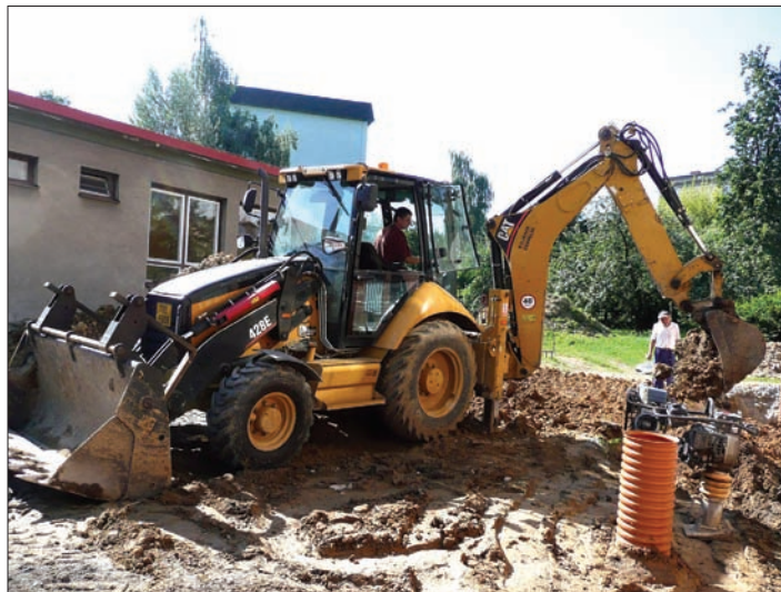
Oprava hydroizolace na ZŠ 1. máje.
