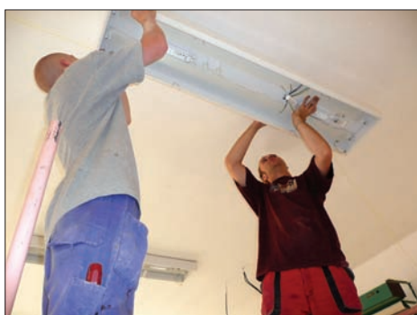
Instalace nových osvětlovacích těles v poslušárně vysoké školy na Nezvalově ulici.
