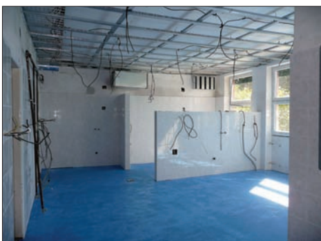
Prostory rekonstruované kuchyně na MŠ U Topolů ve fázi pokládání hydroizolační podlahy.
