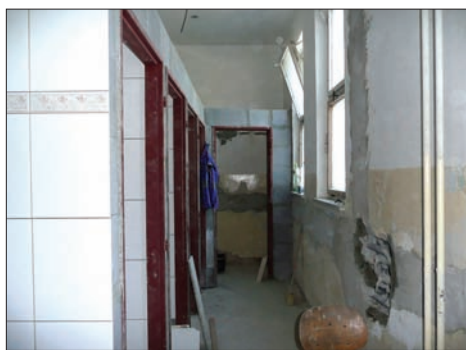
Přestavba sociálních zařízení na ZŠ M. Kudeřkové.
