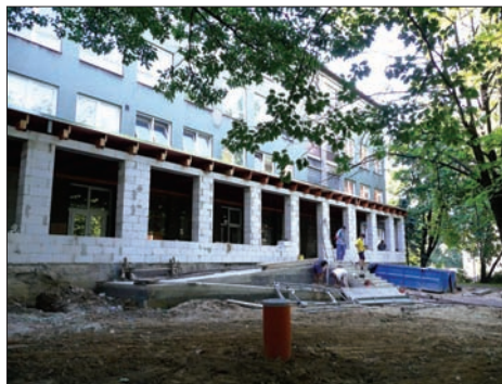
Budova školy na Nezvalově ulici prochází kompletní rekonstrukcí, mění se interiér i exteriér.
