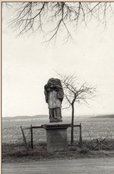
Poškozená socha sv. Jana Nepomuckého u silnice, 70. léta 20. století
