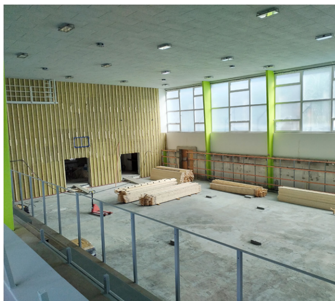
Příprava na pokládku podlahy
