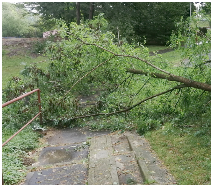
Schodiště na ulici Pavlouskova
