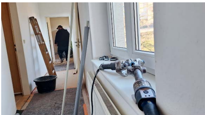
V domě se mění vodovodní i odpadní potrubí
