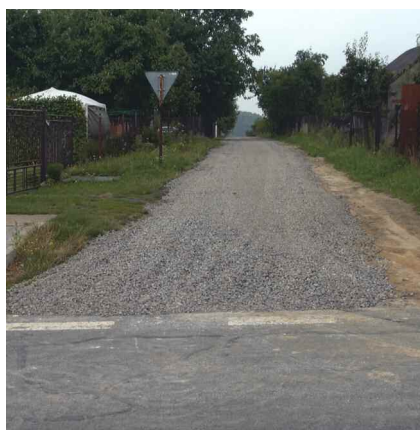
Místní komunikace – ulice U Pískovny (datum snímku 5.8.2009)
