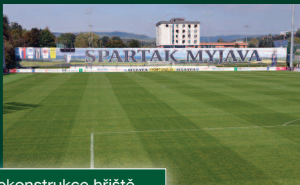
Rekonstrukce hřiště s instalací vyhřívání TJ Spartak Myjava 2014
