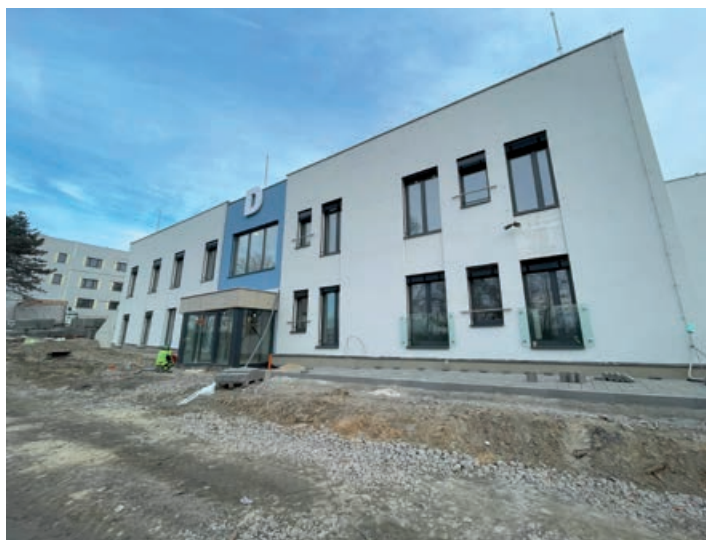
Rekonstrukce Domova Březiny v Petřvaldě.
