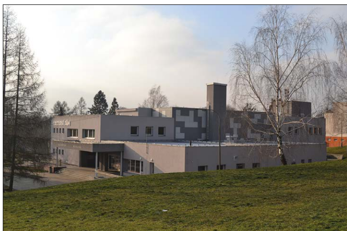
Realizace energetických úspor Kulturního domu v Petřvaldě
