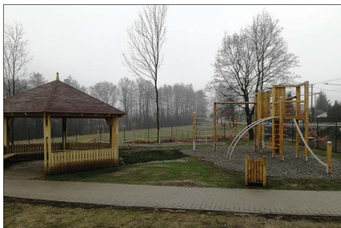
Výstavba víceúčelového hřiště na ul. Šumberská
