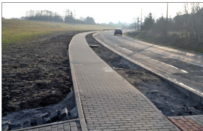
Chodník podél ul. Šumberská
