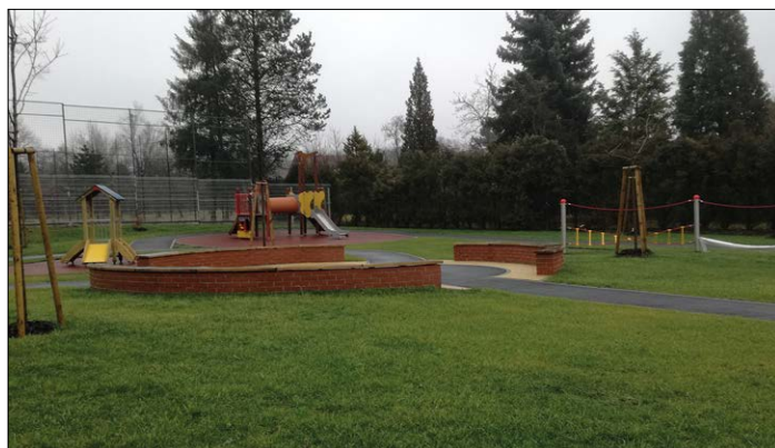
Rekonstrukce školní zahrady MŠ na ul. Šenovská
