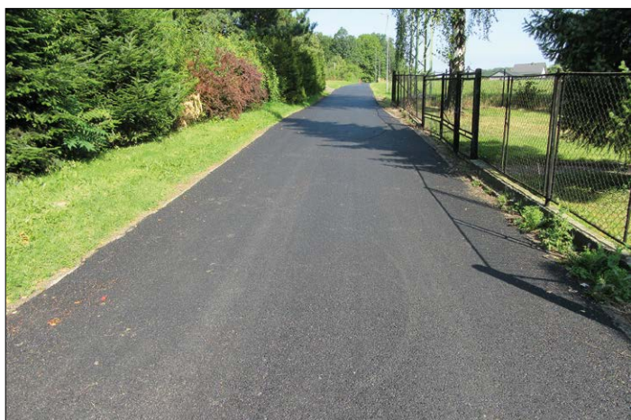
Opravy místních komunikací
