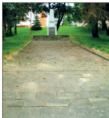
Před zahájením rekonstrukcí
