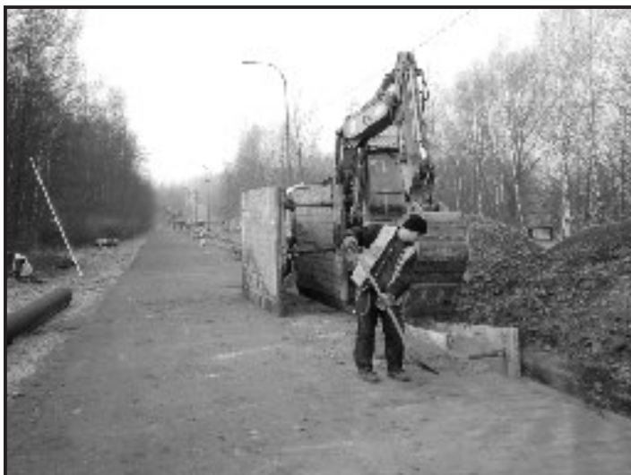
Začátkem měsíce března 2012 byla zahájena sanace a rekonstrukce kanalizační soustavy v důsledku doznívání důlních škod po těžbě uhlí v Petřvaldě na ul. Dolní.
