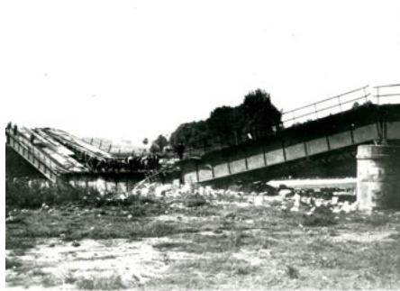
▲ Železniční most v Závadě zničený ustupujícím polským vojskem začátkem září 1939 [SOKA Karviná]
