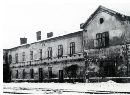
▲ Železniční nádraží v Petrovicích poškozené na konci druhé světové války ustupujícími německými jednotkami [SOKA Karviná]
