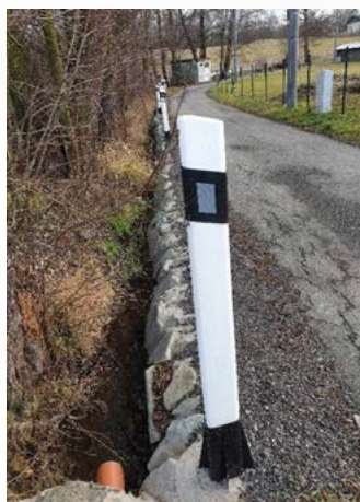
● Zpevnění krajnice v Dolních Marklovicích
