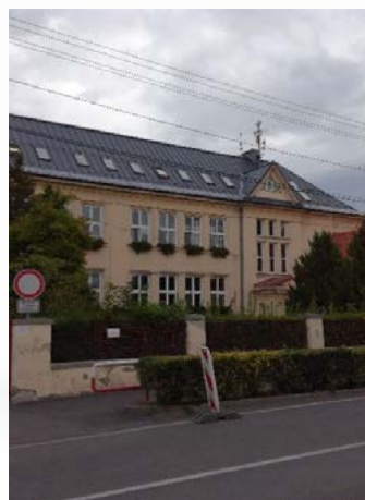
● Výměna střechy na ZŠ v Petrovicích
