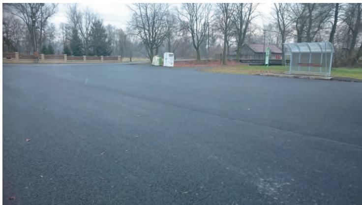
Oprava asfaltové plochy na návsi v Dolních Marklovicích.
