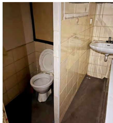
Toaleta s koupelnou před rekonstrukcí
