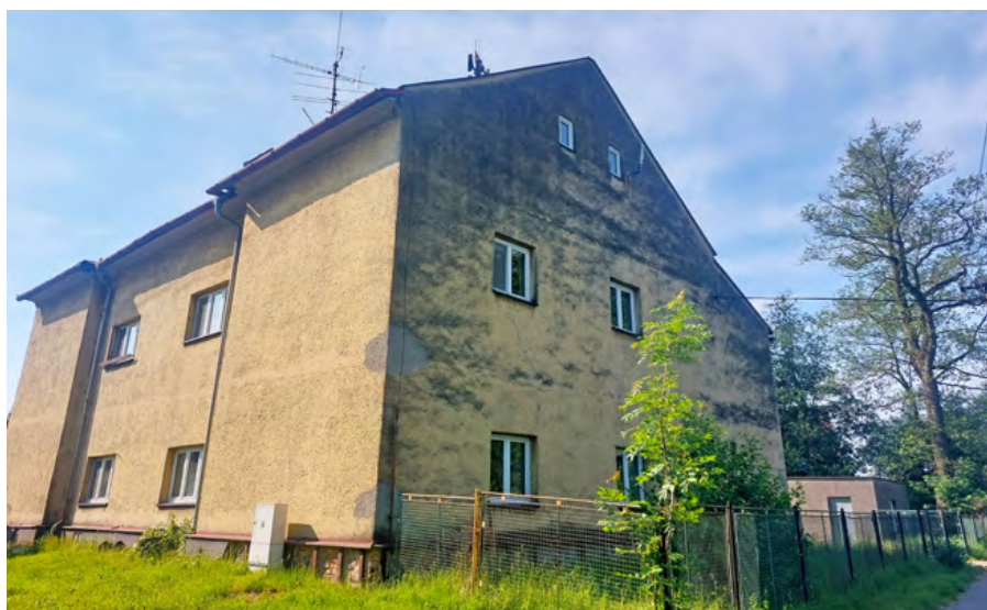
Budova před rekonstrukcí
