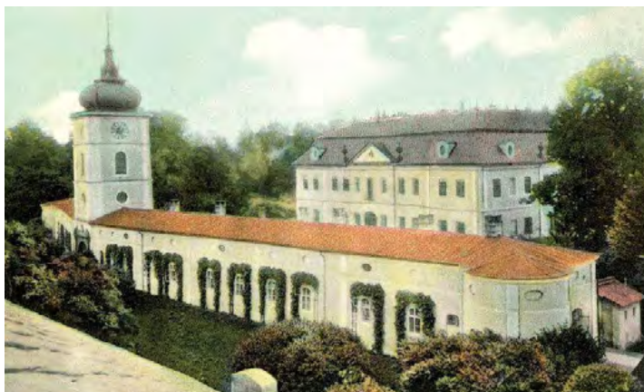
Pohlednice, stav kolem roku 1908, treláže kolem oken
