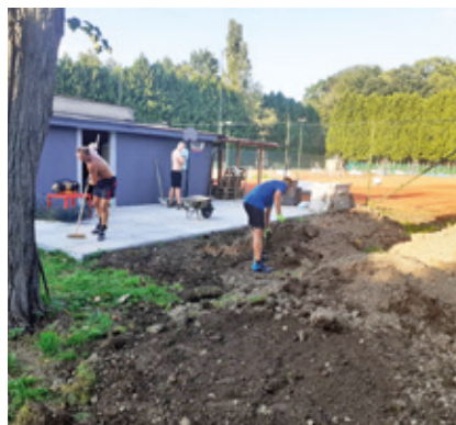
Úprava terénu za tenisovou zdí
