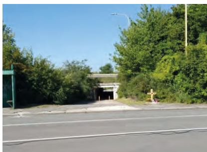
Pohled z ulice U Dálnice na podchod pod dálnicí D56.
