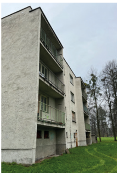
Bytový dům č.p. 675 (panelák v parku)
