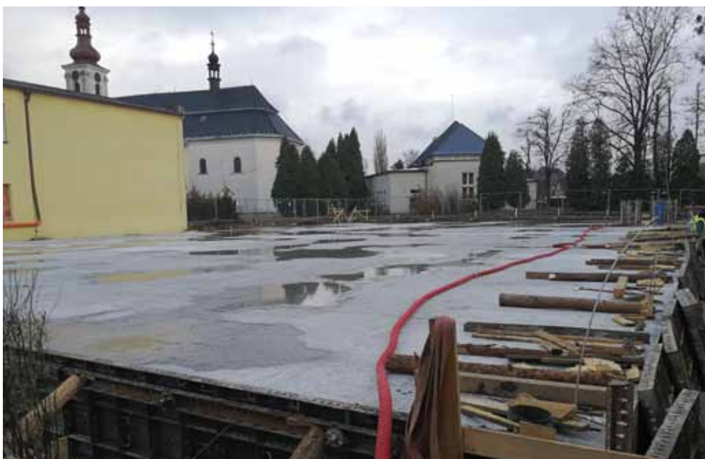
Foto: Základová deska už je hotová.
