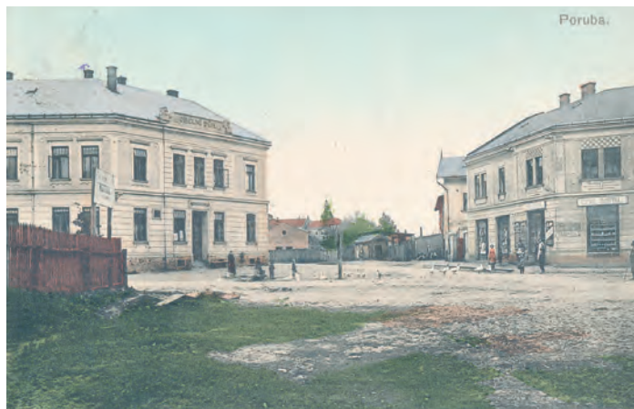
Bývalý obecní dům
